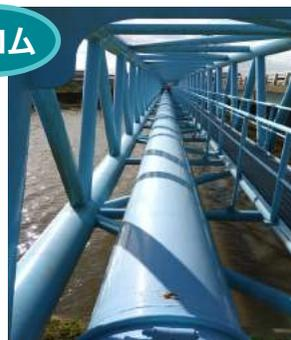
橋梁等の鋼構造体に塗布されている塗膜（塗料）には、PCB や鉛、クロムなどの有害物を含むことが知られています。このため剥離作業を行う上で労働者の健康被害防止の観点から、有害物質含有の事前調査と、施工時の暴露防止対策が必要とされています。
